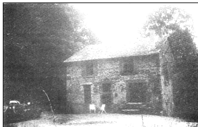
Le bâtiment de l'ancien moulin Montpied à La Gravière
