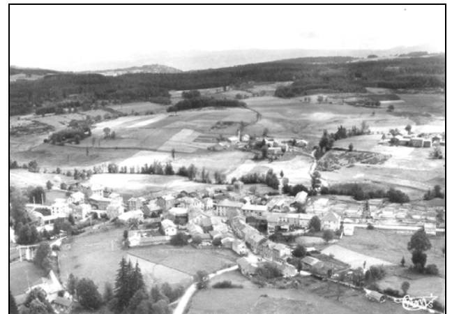
Le bourg de St-Alyre avec, à l'arrière plan, Bressoles (à gauche) et Bressolletes (à droite) (cliché ancien)
