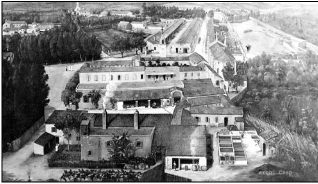
Misserghin : l'ensemble des installations
